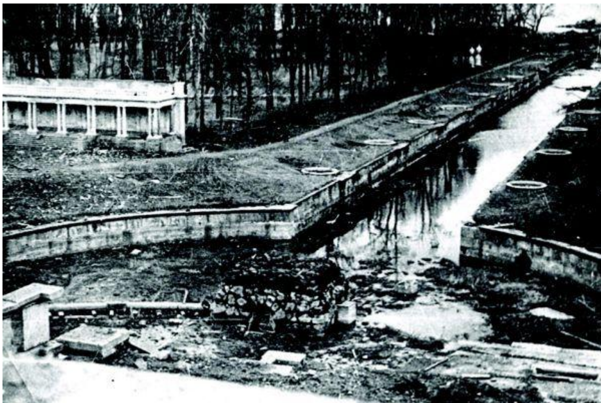
Разрушенный каскад фонтанов
