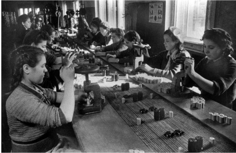
Изготовление взрывателей для минометных снарядов на военном предприятии
